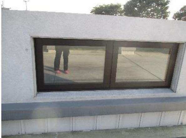
外壁に直接面していない諸室は、自然採光用の窓を設け屋上から光を取り入れています。
